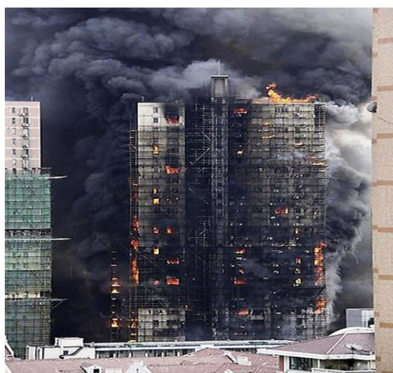
Рис. 39. Пожар в Краснодаре в производственном здании
