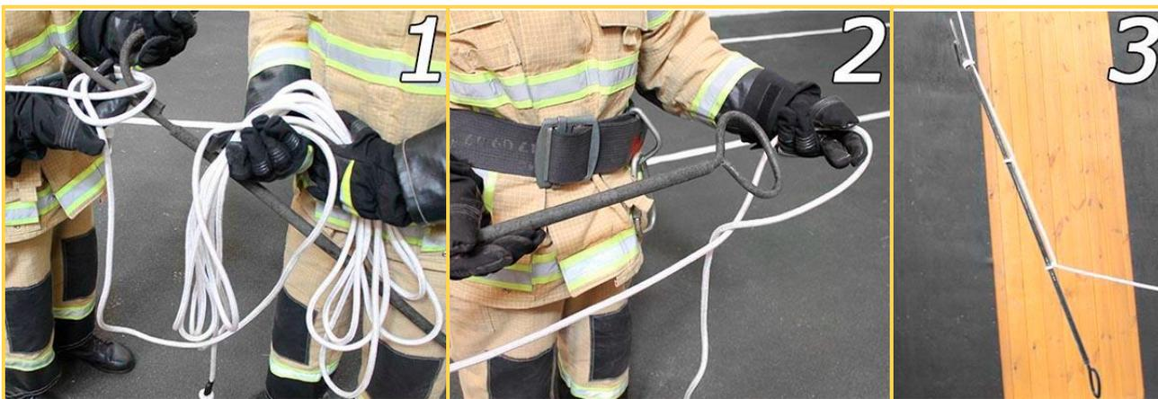
Создать необходимый запас веревки, связать узел «стремя» и надеть его на багор через крюк (1). Сделать два полуштыка запасом веревки через кольцо багра (2). Поднять багор, отводя его от стены здания (3)
