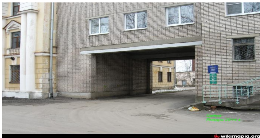
Рис. 37. Сквозные проезды (арки) в зданиях и сооружениях
