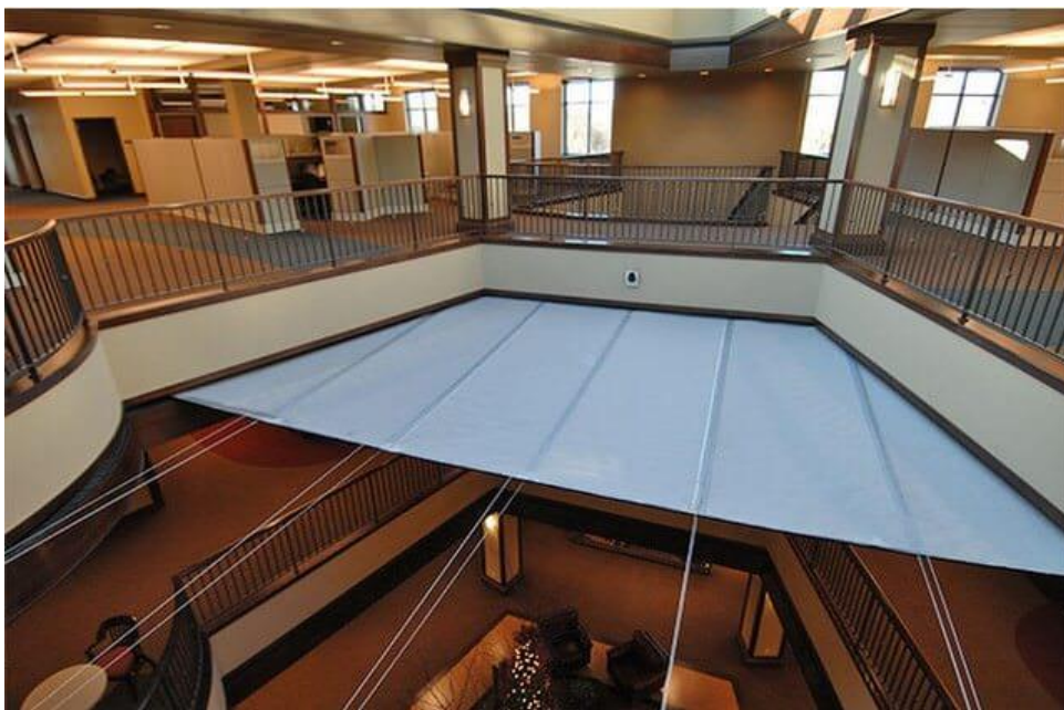
Рис. 16. Горизонтальная противопожарная штора
