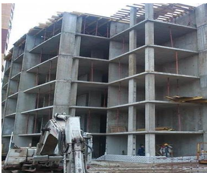
Рис. 7. Конструктивная схема здания с неполным каркасом
