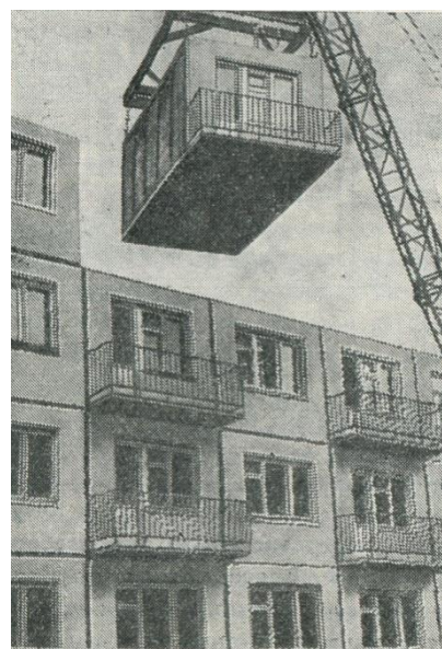
Рис. 24. Объемно-блочная конструктивная система
