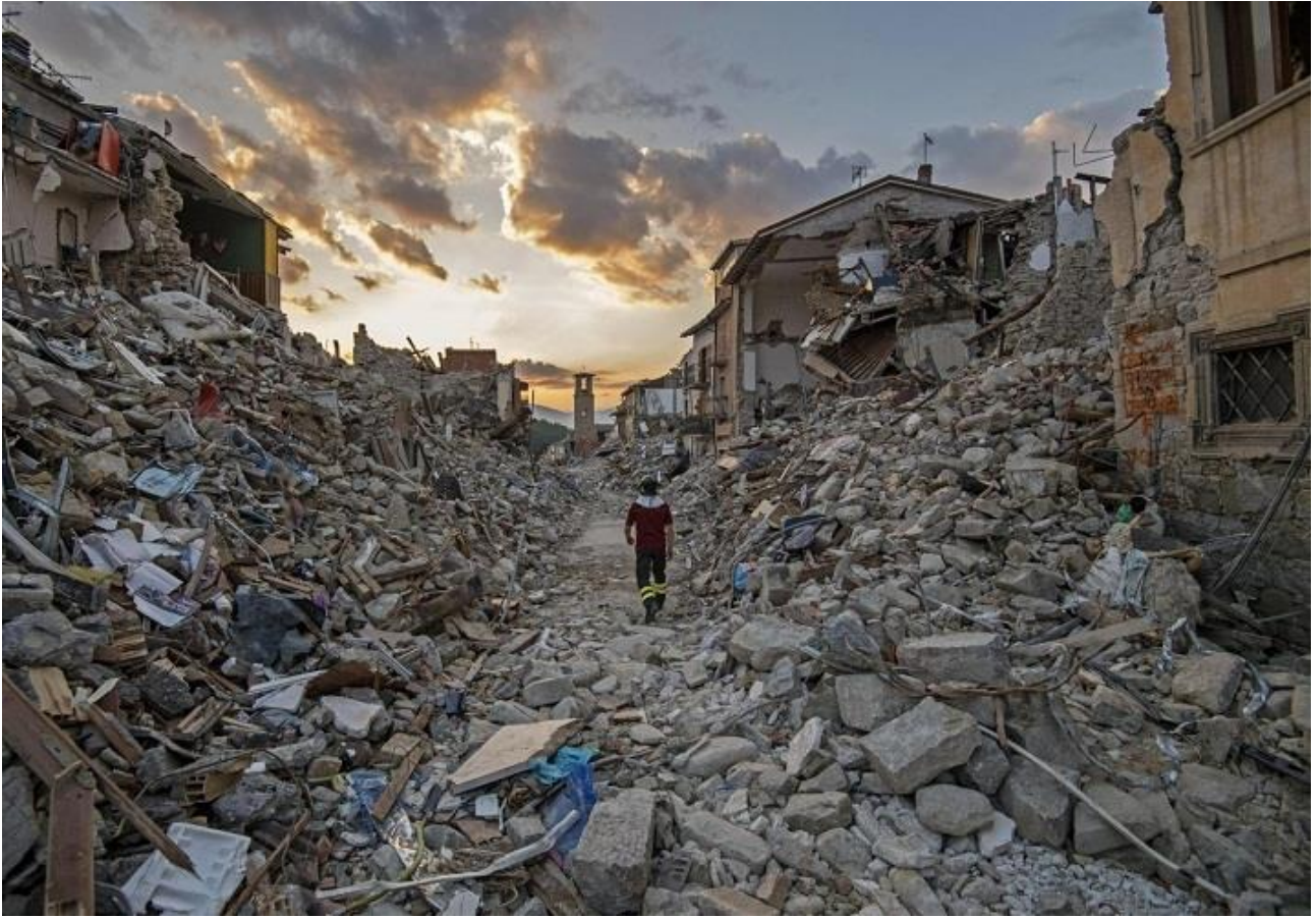
Рис. 7.8. Разрушение в результате землетрясения
