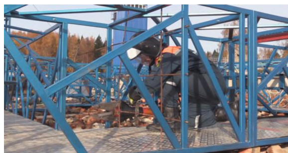
Рис. 4. Перекусывание стальной арматуры
