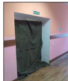
Рис. 2. Отдельные элементы дымонепроницаемой мембраны в сложенном состоянии
