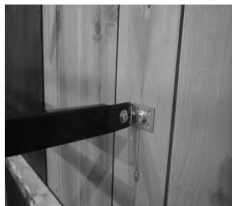
Рис. 6. Крепление устройства фиксации к учебной башне
