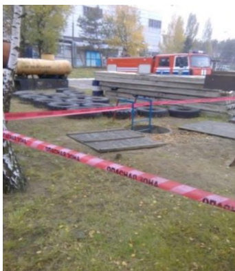
Рис. 1. Ограждение территории около колодца
