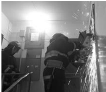
Рис. 1. Операции по резке элементов входной двери
