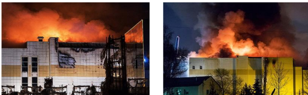
Рис. 1. Пожар в ТРК «Зимняя вишня», г. Кемерово, 25 марта 2018 г.
