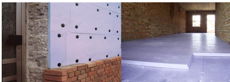
Рис. 1. Применение пенополистирольных плит при утеплении стен
