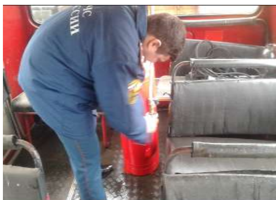
Рис. 1. Монтаж установки пожаротушения в салоне автобуса
