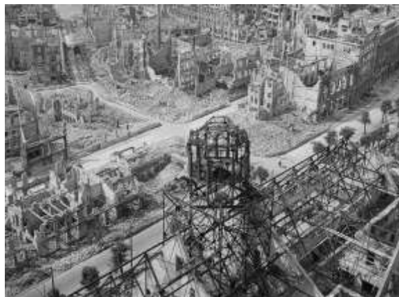
Рис. 2. Фото разрушенный в ходе авианалётов с 13 по 15 февраля 1945 года г.Дрезден [11]
