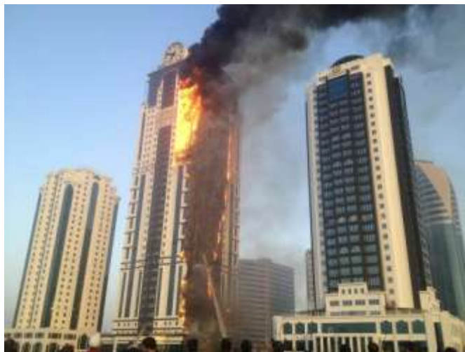
Рис 1. Многофункциональный комплекс «Грозный-Сити», расположенный на проспекте Ахмата Кадырова
