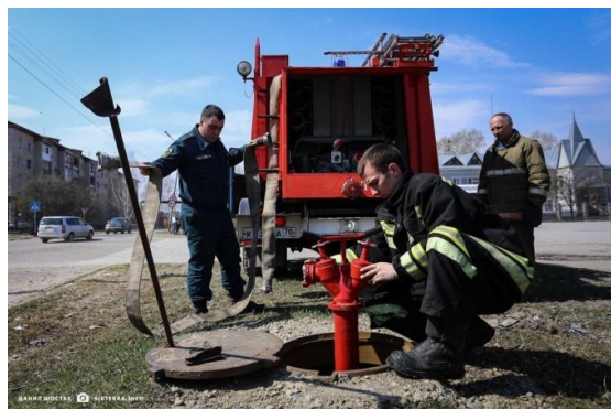
Рис. 3. Метод обследования при помощи автонасоса
