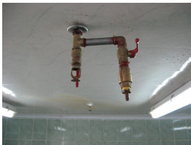
Рис. 2. Внешний вид оросителей, установленных взамен модернизированных [1]
