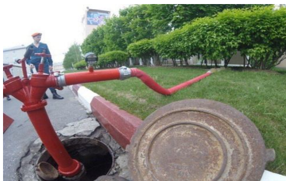
Рис. 2. Метод определения расхода с помощью показания манометра
