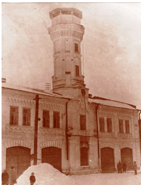
Рис. 1. Депо пожарной команды г.Усть-Сысольск
