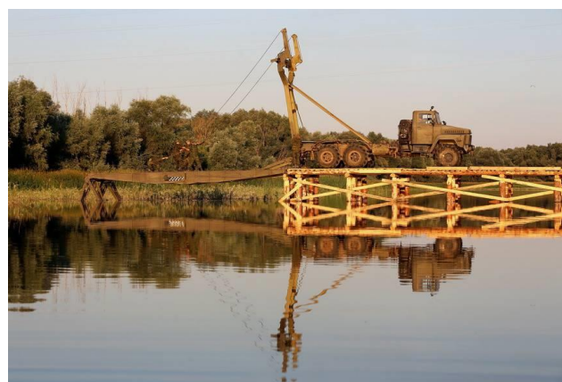
Рис. 2. Отремонтированный ТММ 3 мост
