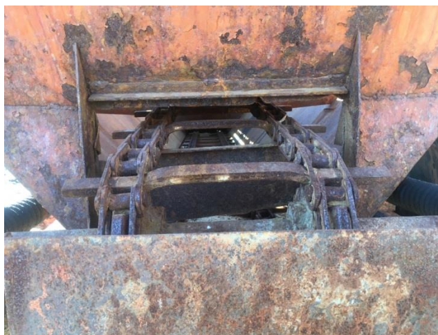
Рис. 2. Вид на установку цепи
