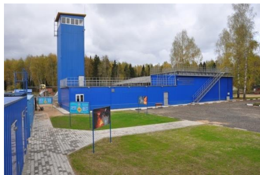
Рис. 1. Многофункциональный тренажерный комплекс подготовки газодымозащитников
