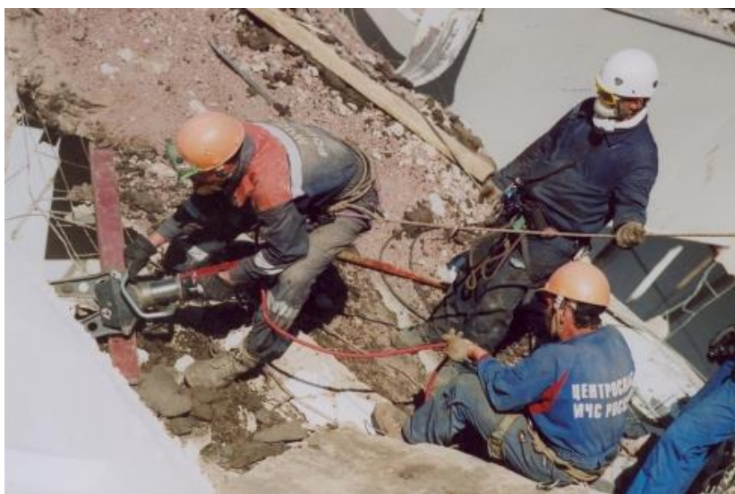
Рисунок. Выполнение АСР при помощи гидравлического аварийно-спасательного инструмента
