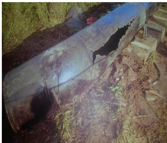
Рисунок. Разгерметизация магистрального нефтепровода «Сургут-Полоцк», с выходом нефти на поверхность земли и ее последующим возгоранием
