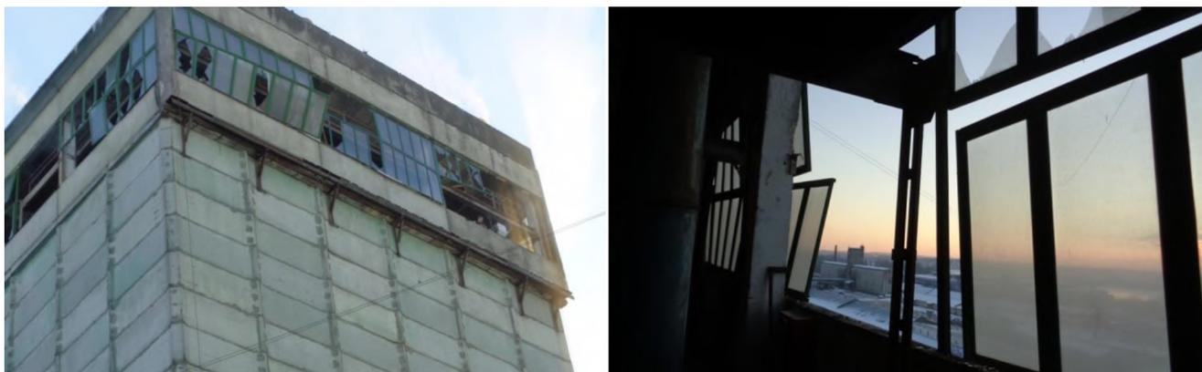
**Рис. 1.** Внешний вид здания после взрыва
