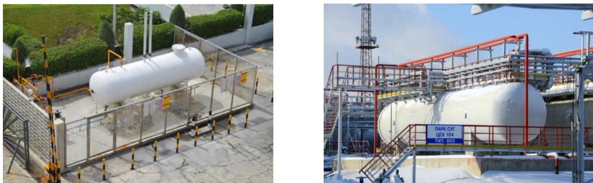
Рис. 1. Примеры ограждений и расположений площадок резервуаров со СУГ
