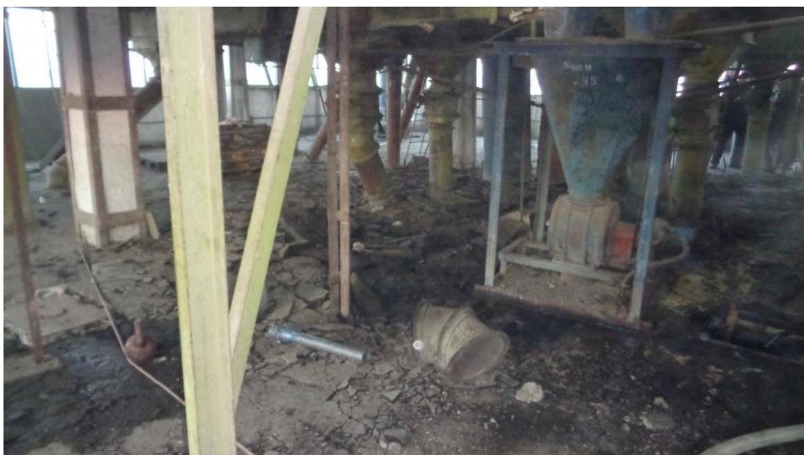
**Рис. 2.** Внешний вид пола после взрыва
