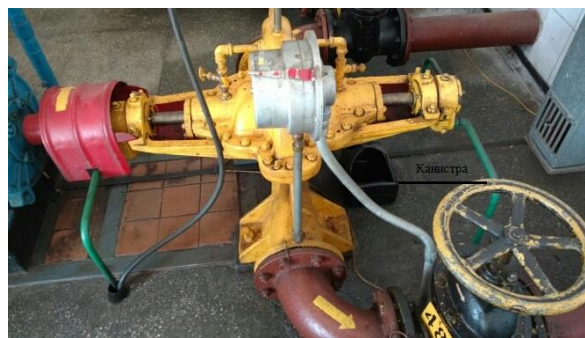
Рис. 2. Сбор капельной утечки бензина через фланцевое соединение в канистру
