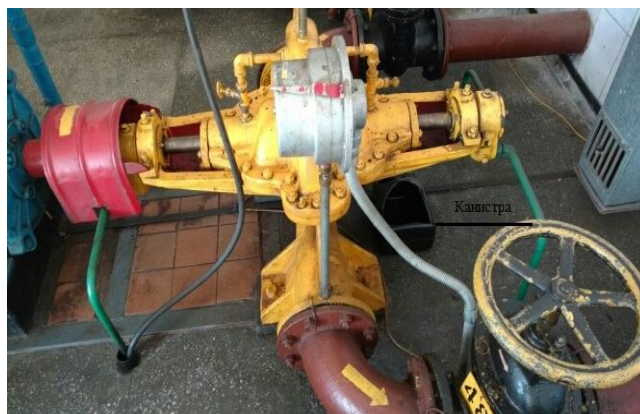
Рис. 3. Сбор капельной утечки бензина из фланцевого соединения в канистру
