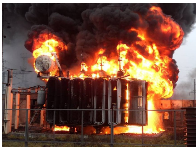
Рис. 1. Пожар трансформатора
