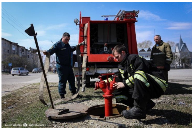
Рис. 4. Метод обследования при помощи автонасоса
