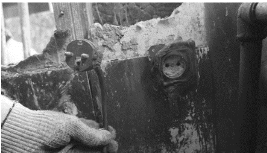
Рис. 2. Фото розетки, к которой подключалась насосная станция
