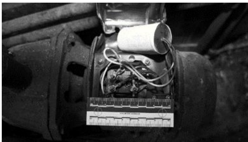
Рис. 5. Фото блока управления электродвигателя насосной станции с открытой крышкой
