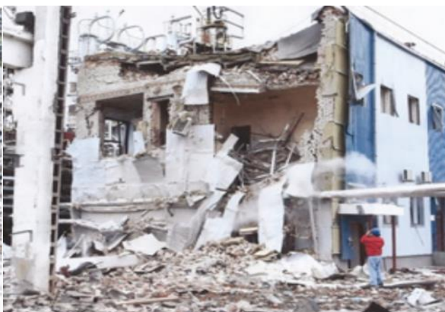
Рис. 3. Последствия аварии в ООО ПО «Киришинефтеоргсинтез» а – разрушенное здание компрессорной; б – здание операторной установки ЛГ-24/7-1200
