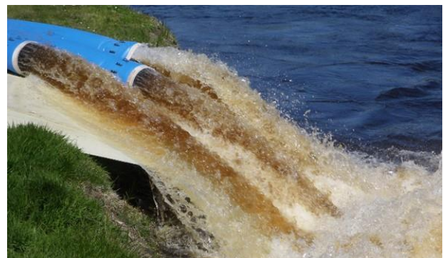
Рис. 5. Общий вид перекачки воды при помощи модуля «Наводнение»
