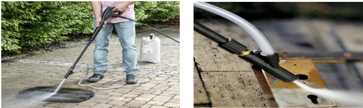
Рисунок 2 – Применение мойки высокого давления для обработки поверхности материала:
