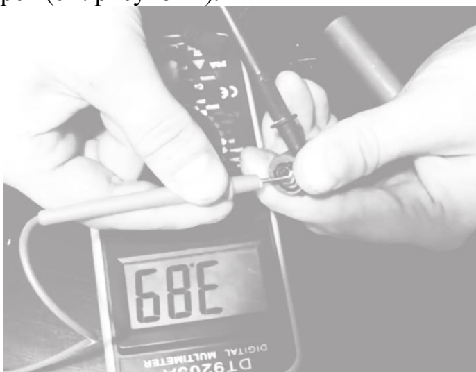
Рисунок 4 - Результат аварийного режима работы аккумуляторной батареи
