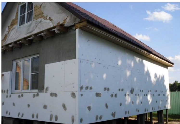
Рисунок 1 - Применение пенополистирольных плит при утеплении стен
