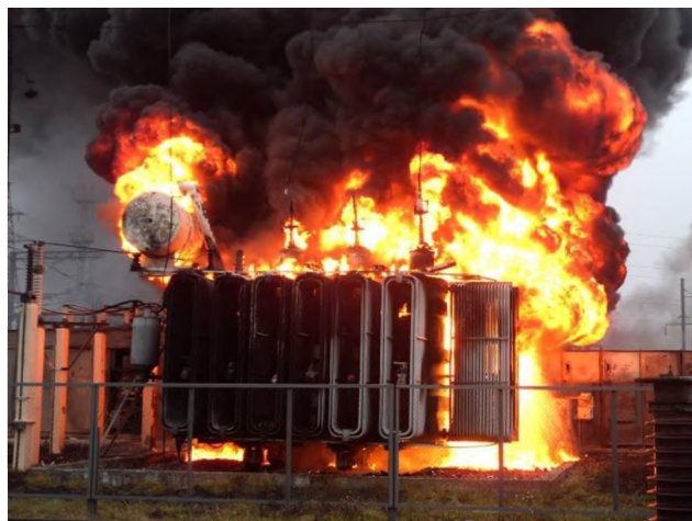
Рис. 1. Пожар трансформатора
