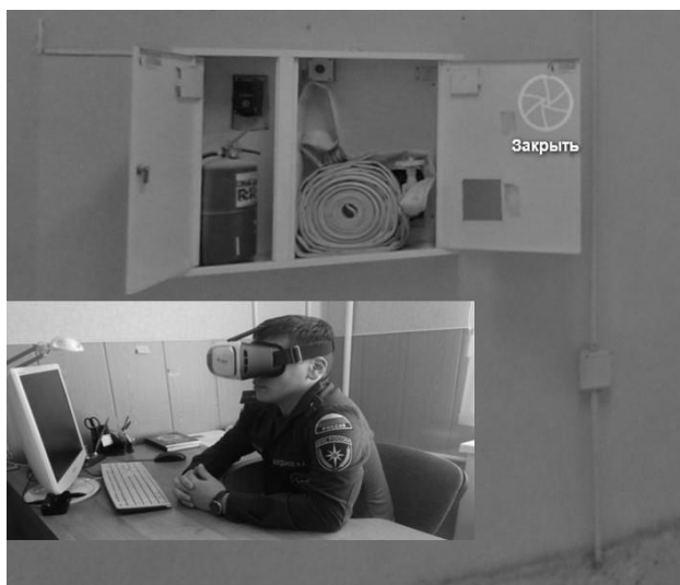
Рис. 4. Осмотр объекта с использованием очков виртуальной реальности
