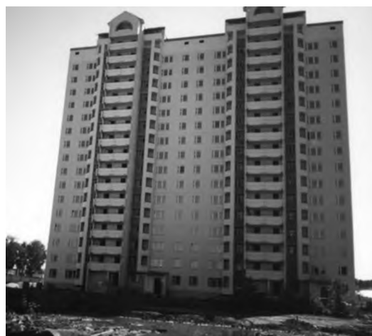
Рис. 1. Главный фасад обследуемого здания
